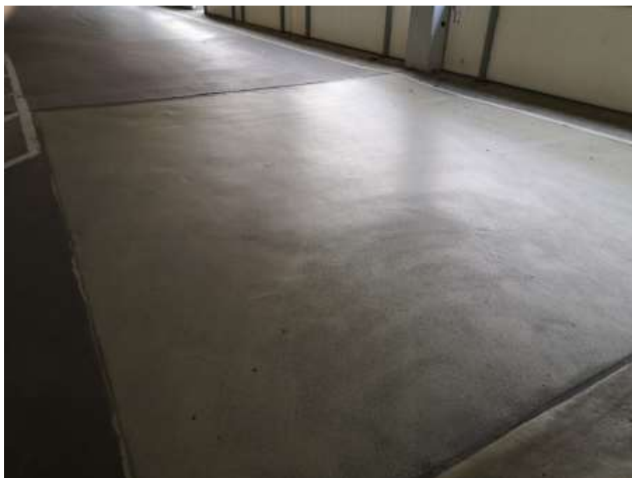
Figur 2.17 Polyuretan Mapefloor PU på parkeringsdäcket i Kville 2019
