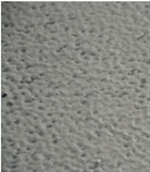
Figur 2.32 Polyurea Micorea HS med vidhäftningsförlust och gropar efter drygt 3 år på parkeringsdäcket i Baggen
