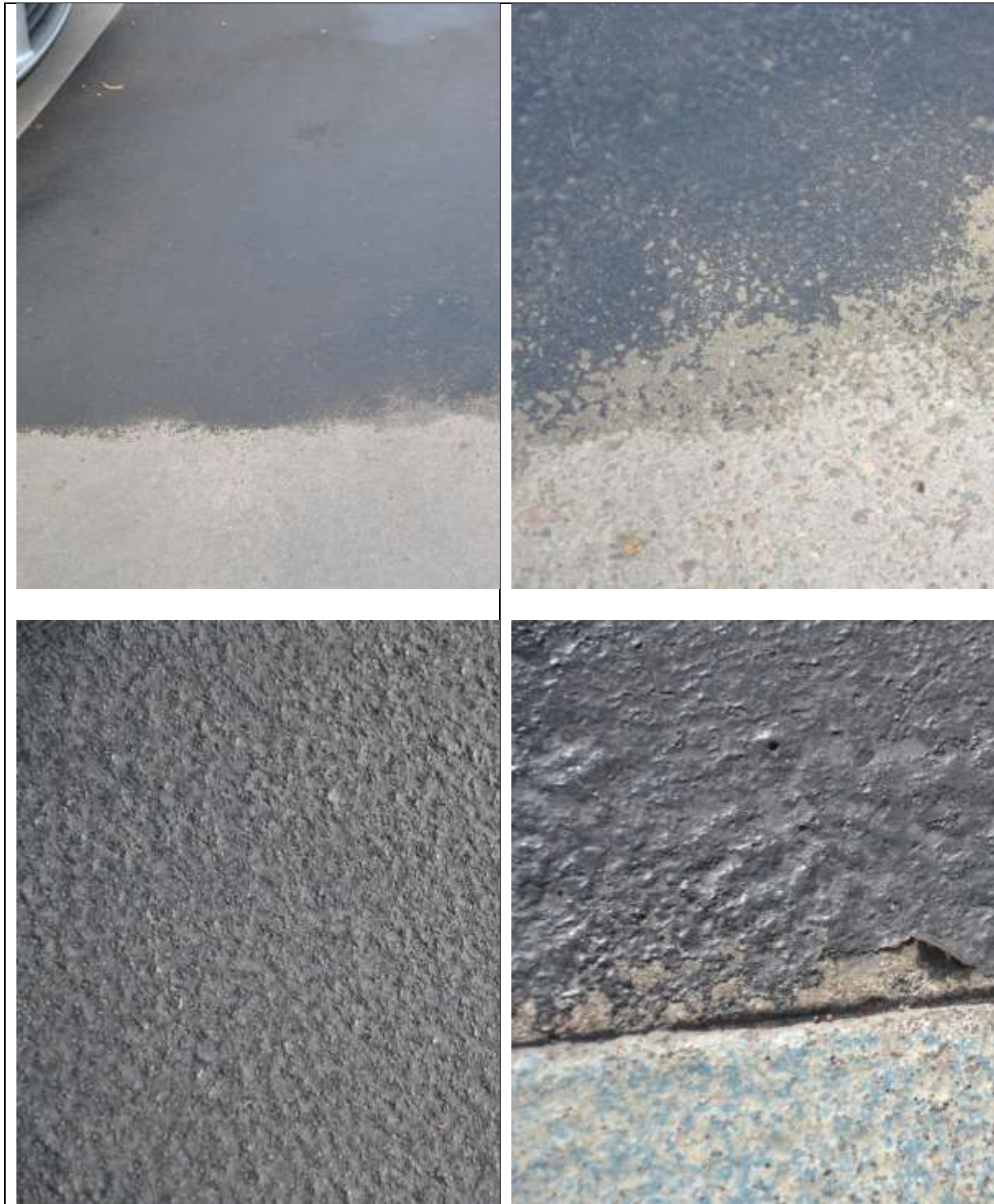
Figur 2.29 Polyurea Purtop efter 4 år på parkeringsdäcket i Baggen 2019
