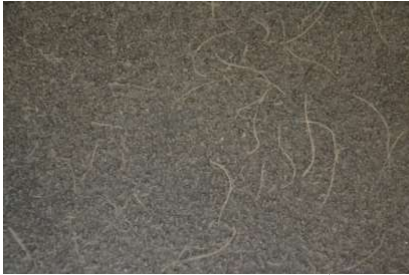
Figur 2.18 Akryl Duracon på parkeringsdäcket i Åkeshov 2019
