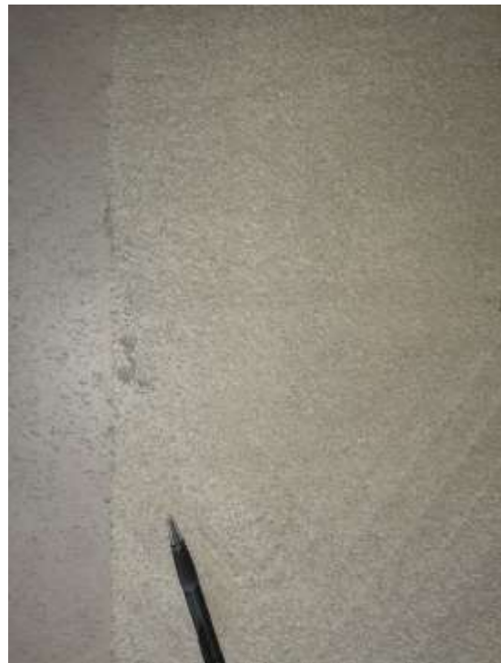
Figur 2.12 Ytligt slitage efter dubbdäck på Polyuretan Conideck 2255 efter 6 år på parkeringsdäcket i Kville
