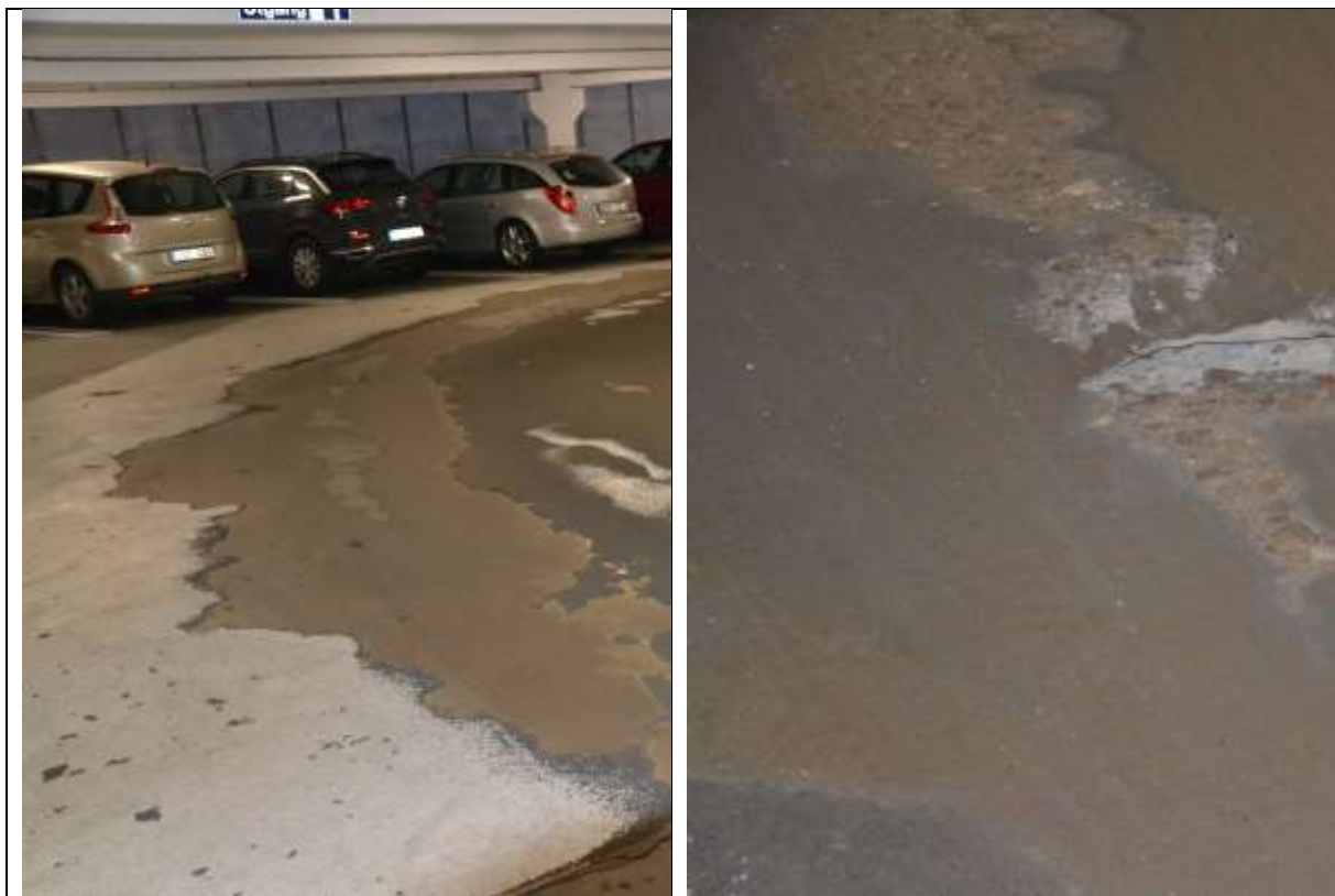
Figur 1.1 Betongskador i garage - Olämpligt val av beläggningssystem. Foto: Ylva Edwards
