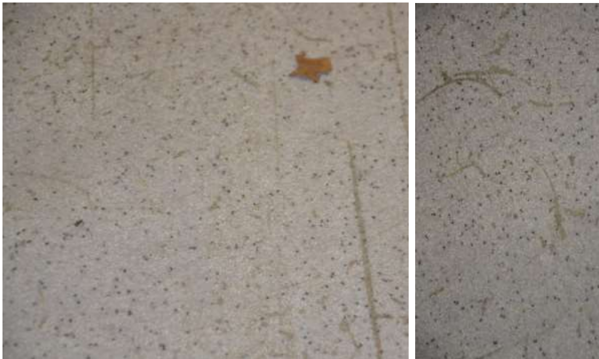
Figur 2.17 Ytligt slitage efter dubbdäck och burnout på Akryl Silikal Dekor efter 5 år på parkeringsdäcket i Åkeshov
