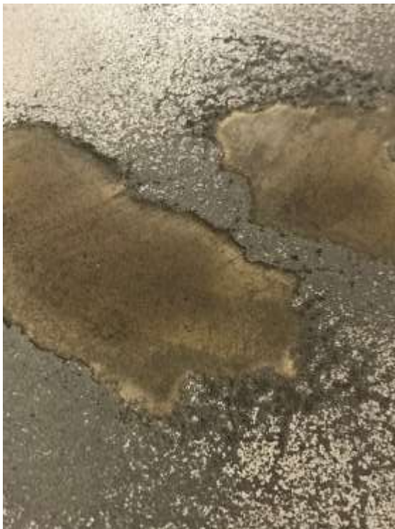
Figur 1.2 Slitageskador på härdplastbeläggningar efter kort tid i bruk. Foto: Ylva Edwards
