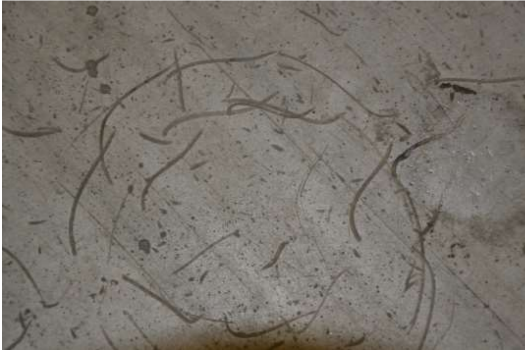
Figur 2.24 Epoxi Micopox på parkeringsdäcket i Åkeshov 2019
