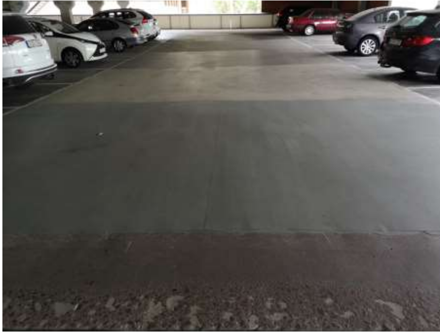
Figur 2.5 Polyuretan Sikafloor på parkeringsdäcket i Kville 2019
