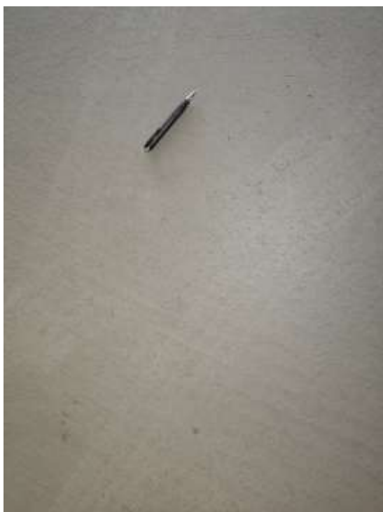
Figur 2.10 Ytligt slitage efter dubbdäck på Polyuretan Deckshield ID efter 6 år på parkeringsdäcket i Kville
