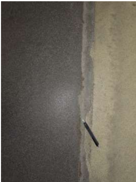
Figur 2.16 Gropar och ytligt slitage efter dubbdäck på Polyurea Micorea S3 efter 6 år på parkeringsdäcket i Kville
