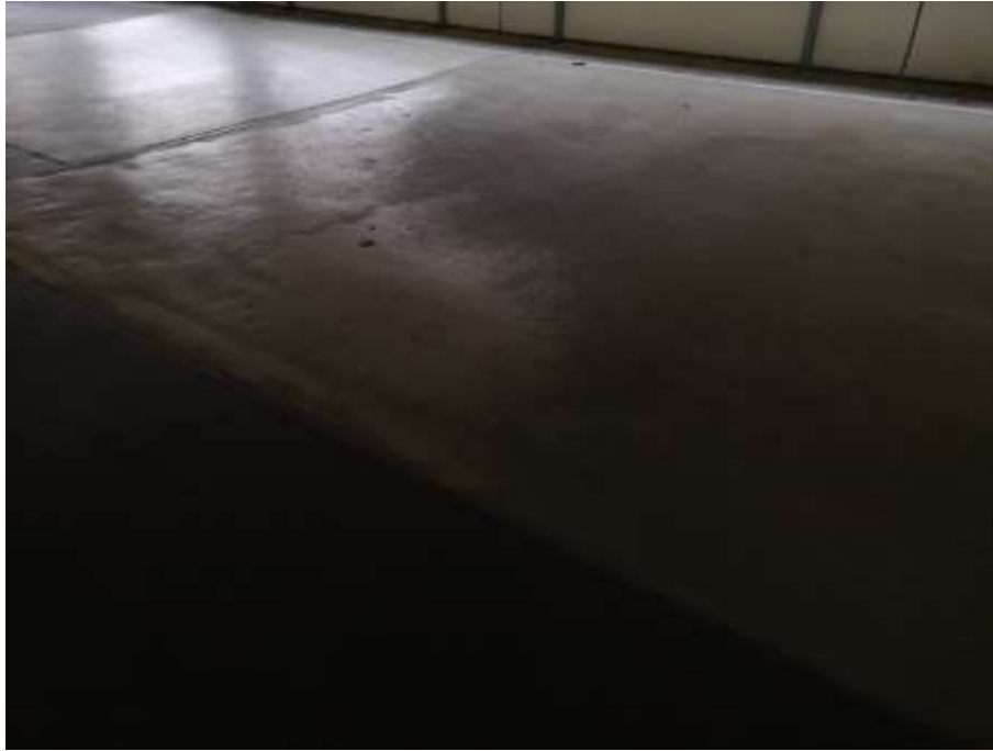
Figur 2.15 Polyurea Micorea på parkeringsdäcket i Kville 2019
