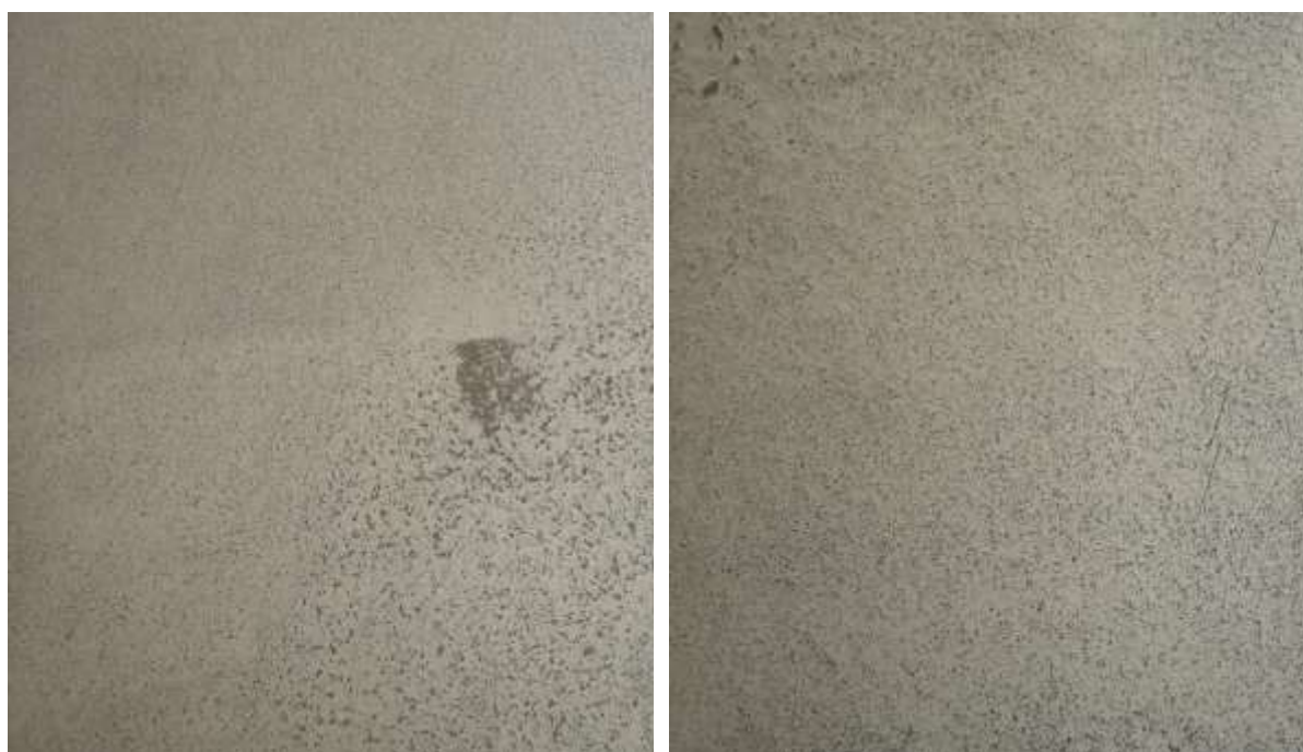
Figur 2.18 Slitage på Polyuretan Mapefloor PU efter 6 år på parkeringsdäcket i Kville
