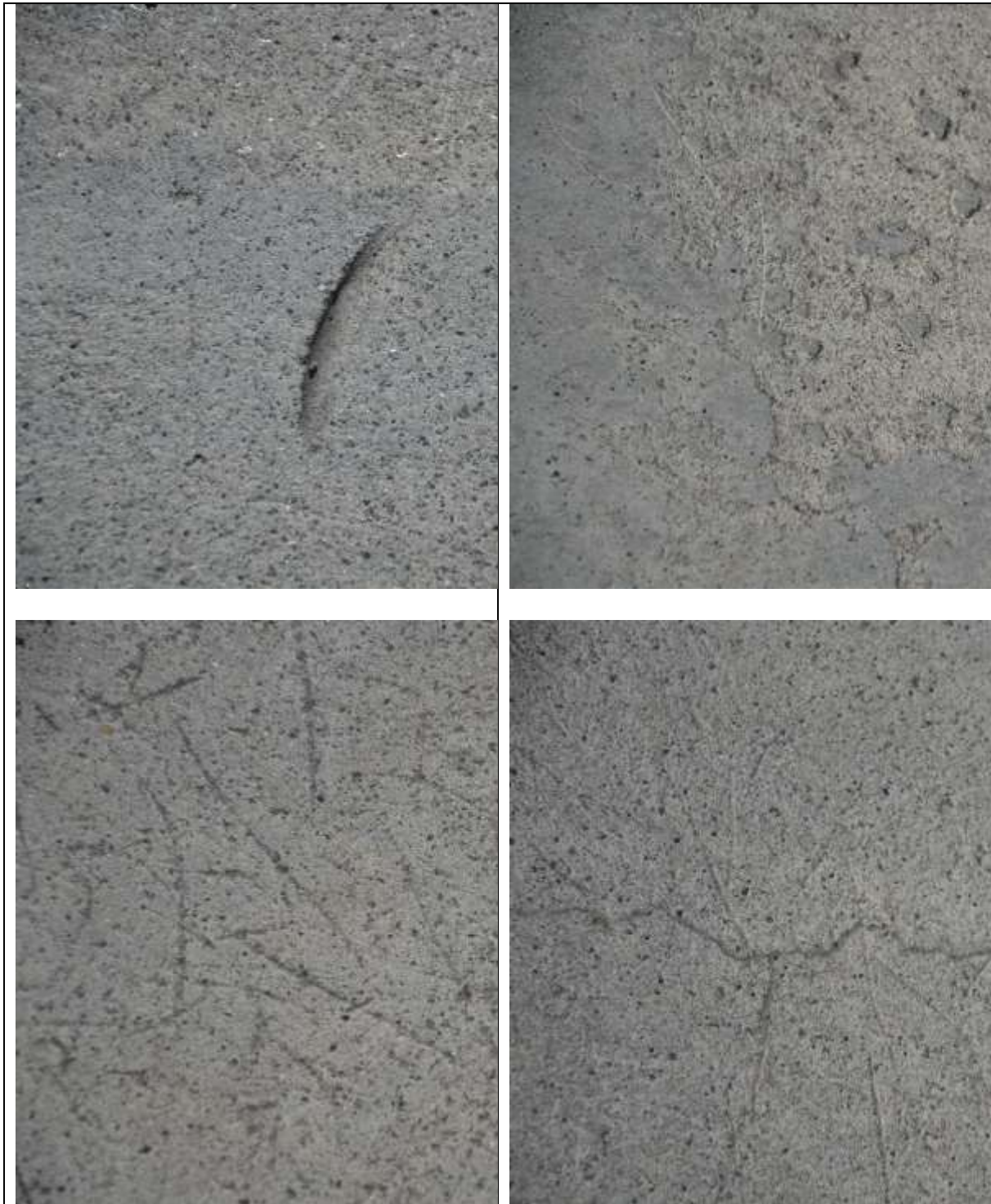
Figur 2.33 Hårdbetong Sikafloor-1 Concrete med ytligt slitage och gropar efter drygt 4 år på parkeringsdäcket i Baggen 2019
