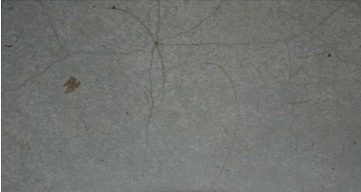
Figur 2.22 Hårdbetong Mastertop på parkeringsdäcket i Åkeshov 2019
