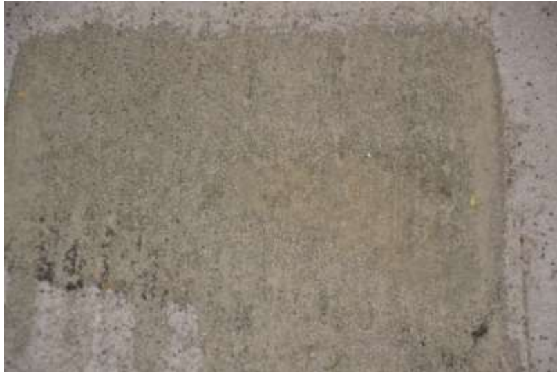
Figur 2.16 Akryl Silikal Dekor på parkeringsdäcket i Åkeshov 2019. Burnout
