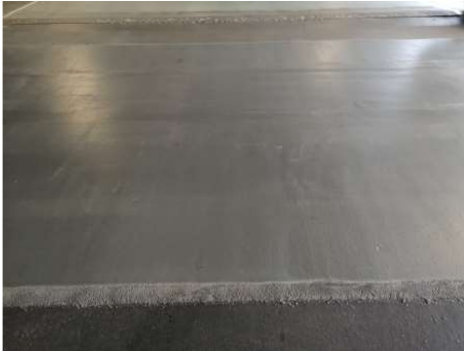
2.3 Hårdbetong Densit på parkeringsdäcket i Kville 2019
