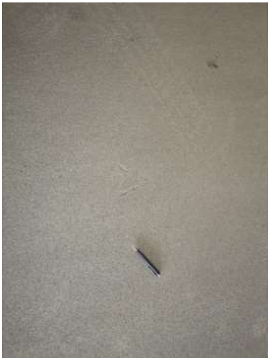
Figur 2.12 Ytligt slitage efter dubbdäck på Polyuretan Conideck 2255 efter 6 år på parkeringsdäcket i Kville
