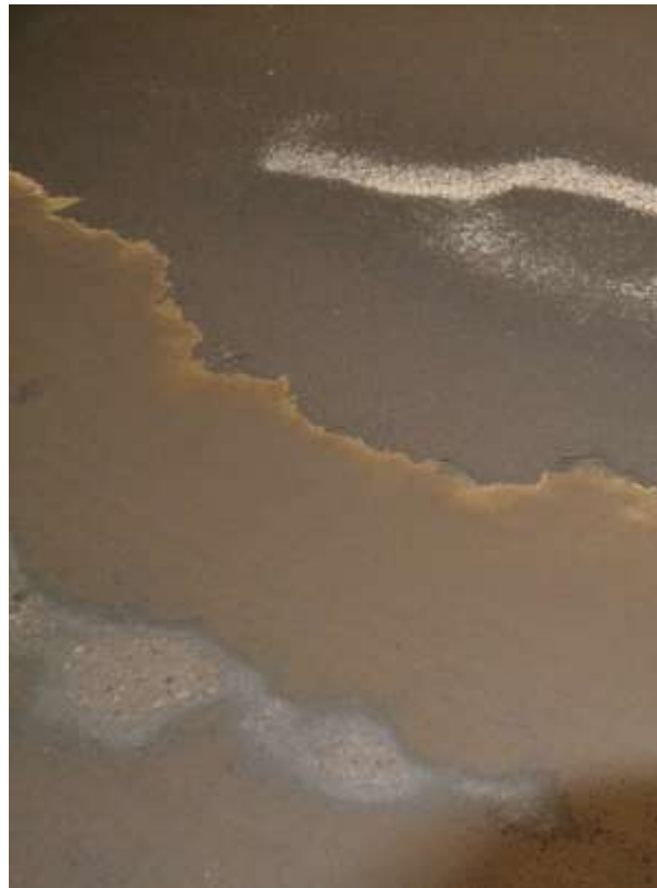
Figur 2.35 Nedsliten beläggning på ramper i Baggen 2019 (ej inom SBUF-projektet)
