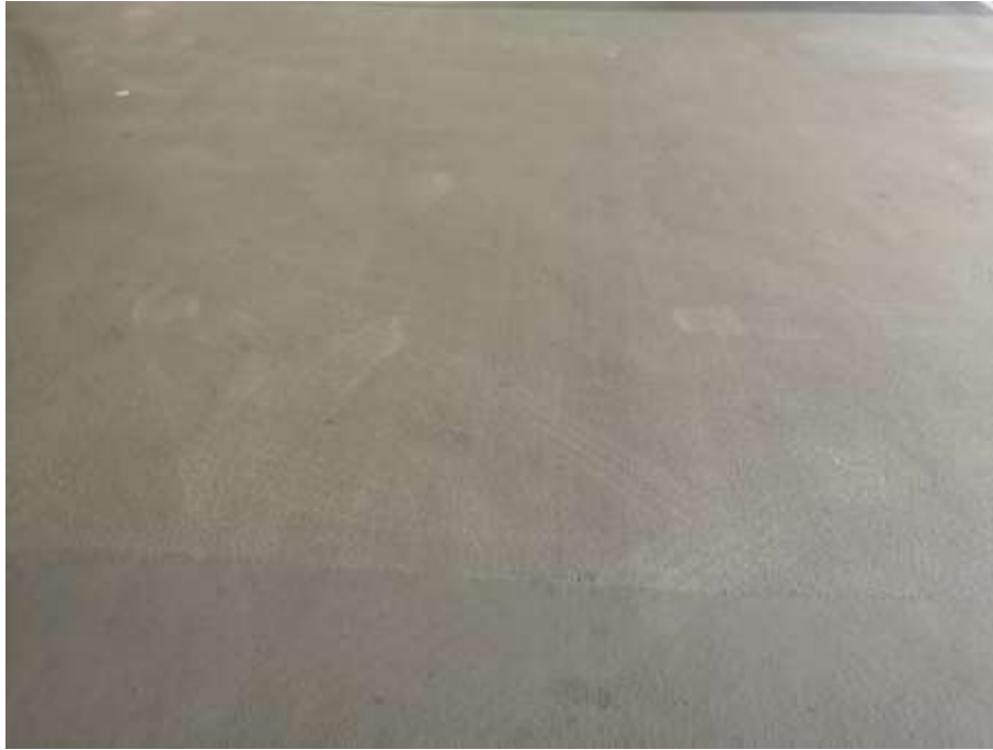
Figur 2.11 Polyuretan Conideck 2255 på parkeringsdäcket i Kville 2019
