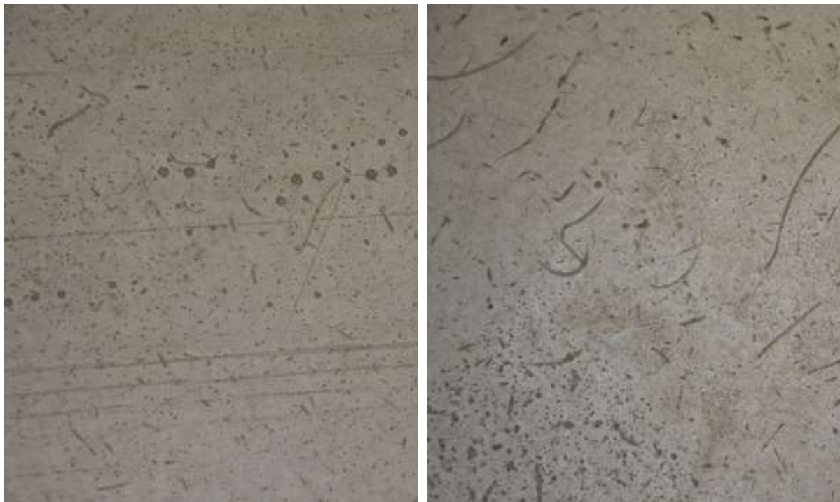
Figur 2.25 Ytligt slitage efter dubbdäck och blåsor på Epoxi Micopox efter 5 år på parkeringsdäcket Åkeshov
