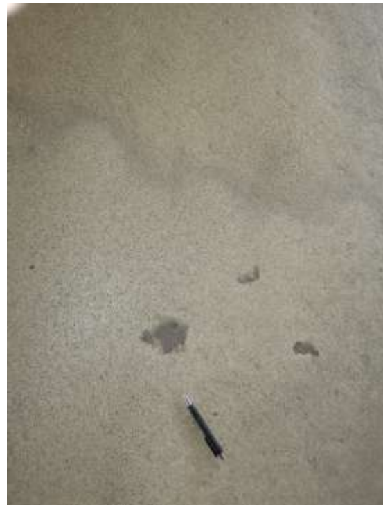
Figur 2.16 Gropar och ytligt slitage efter dubbdäck på Polyurea Micorea S3 efter 6 år på parkeringsdäcket i Kville
