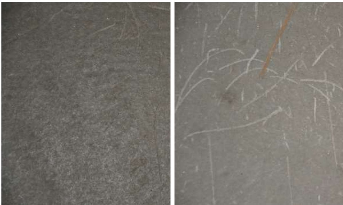
Figur 2.15 Ytligt slitage från dubbdäck på Hårdbetong Intercrete efter 5 år på parkeringsdäcket i Åkeshov
