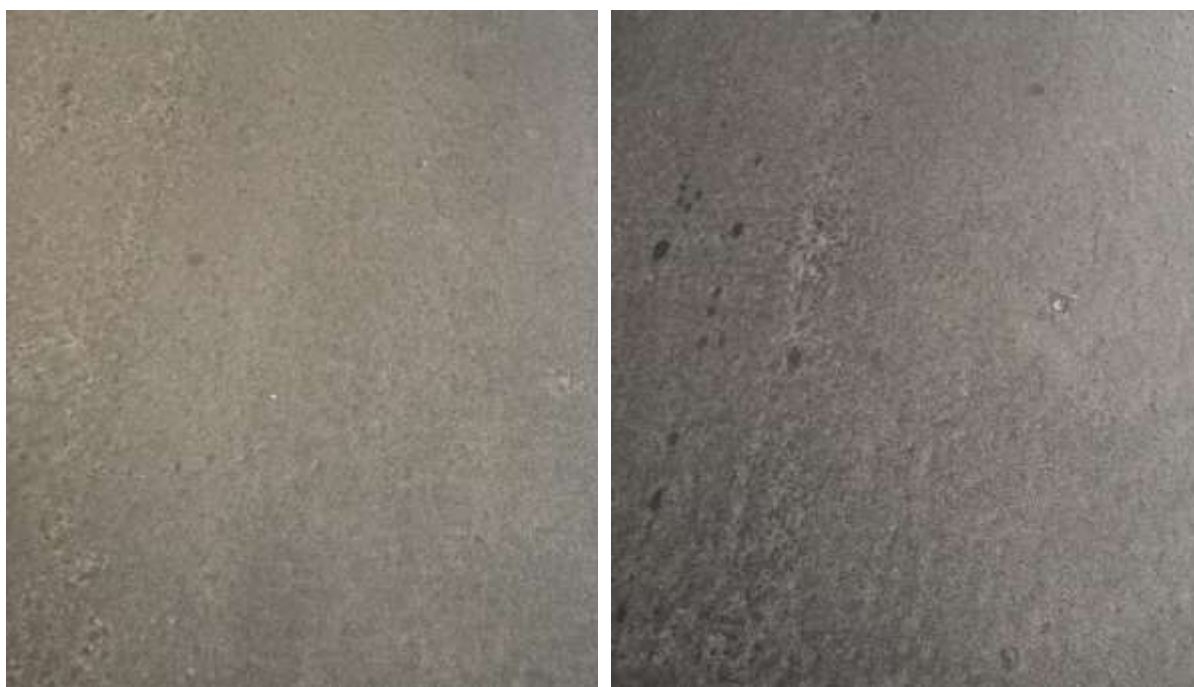
Figur 2.2 PGJA med vax och tätskiktsmatta efter 6 år på parkeringsdäcket i Kville
