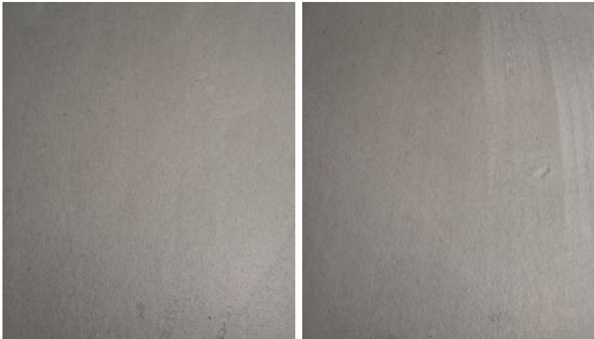
Figur 2.6 Ytligt slitage efter dubbdäck på Polyuretan Sikafloor efter 6 år på parkeringsdäcket i Kville
