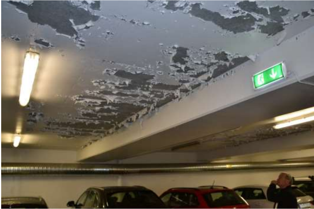
Figur 2.13 Det nymålade taket i parkeringsgaraget i Åkeshov 2019
