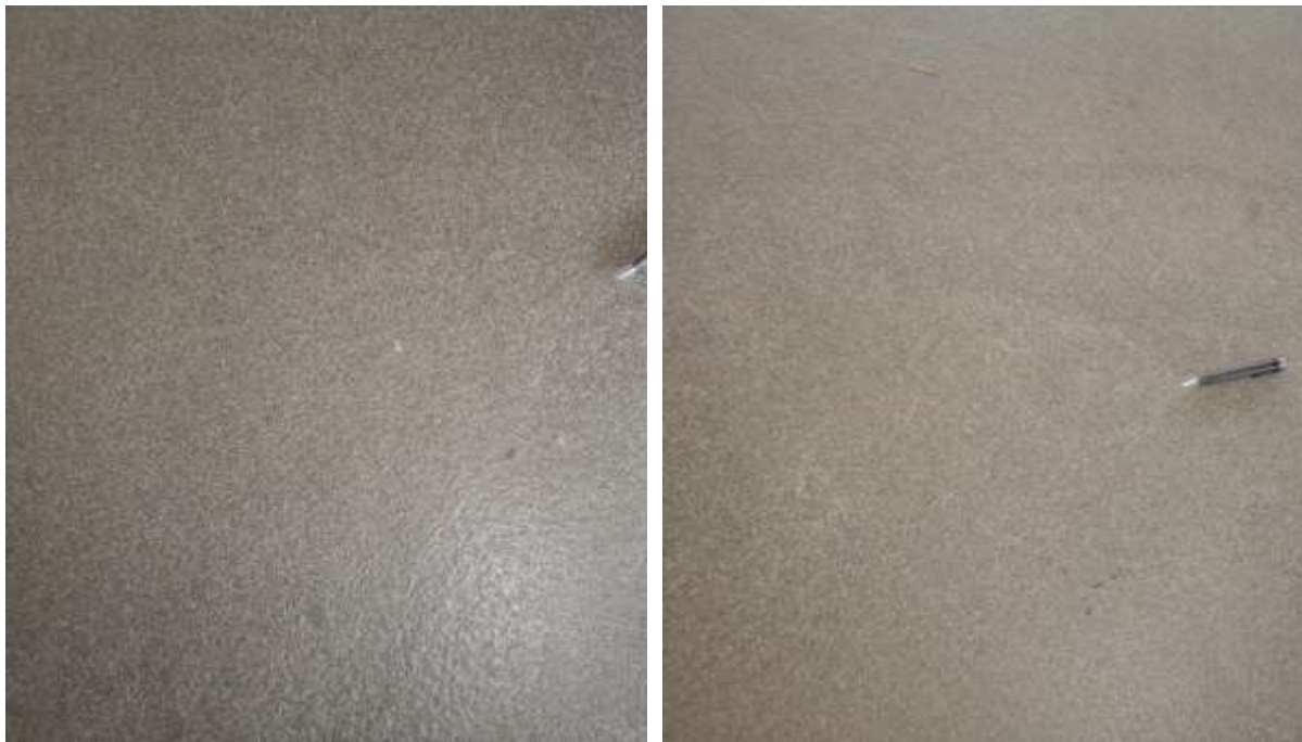
Figur 2.14 Ytligt slitage efter dubbdäck på Akryl Map Pro efter 6 år på parkeringsdäcket i Kville
