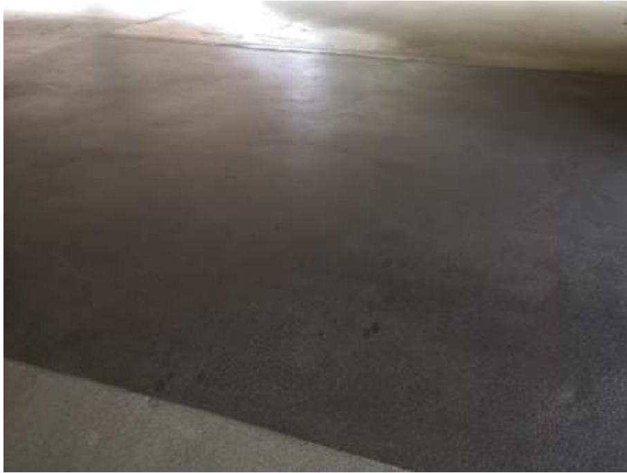
Figur 2.13 Akryl Map Pro på parkeringsdäcket i Kville 2019
