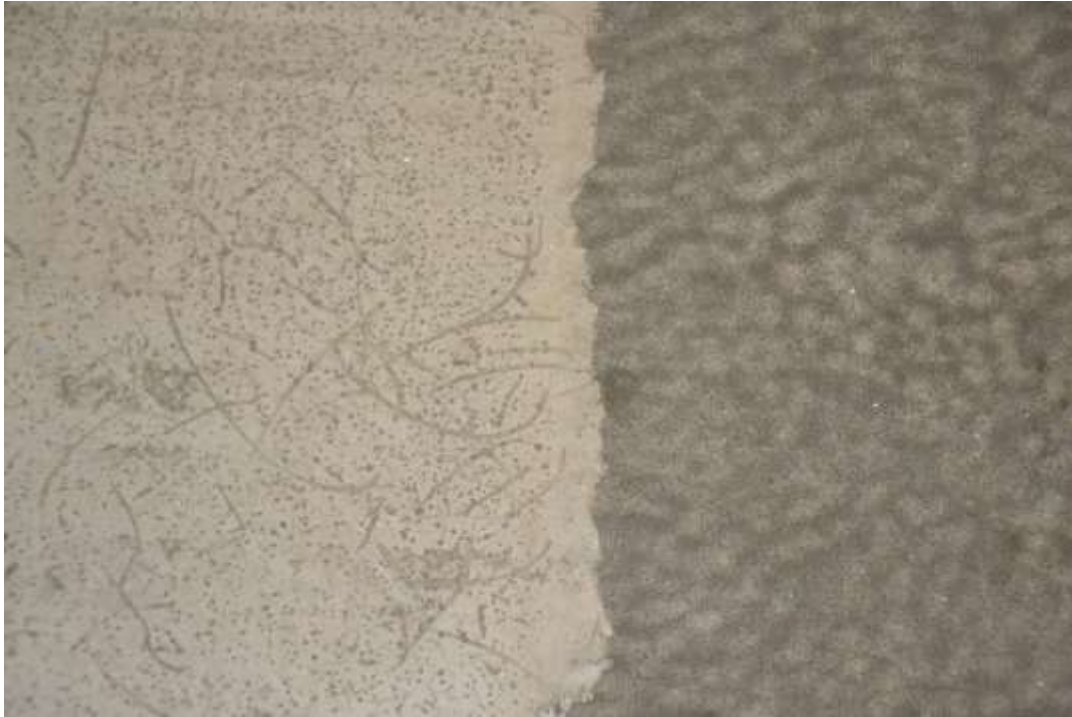
Figur 2.26 Polyurea Micorea på parkeringsdäcket i Åkeshov 2019. Till höger
