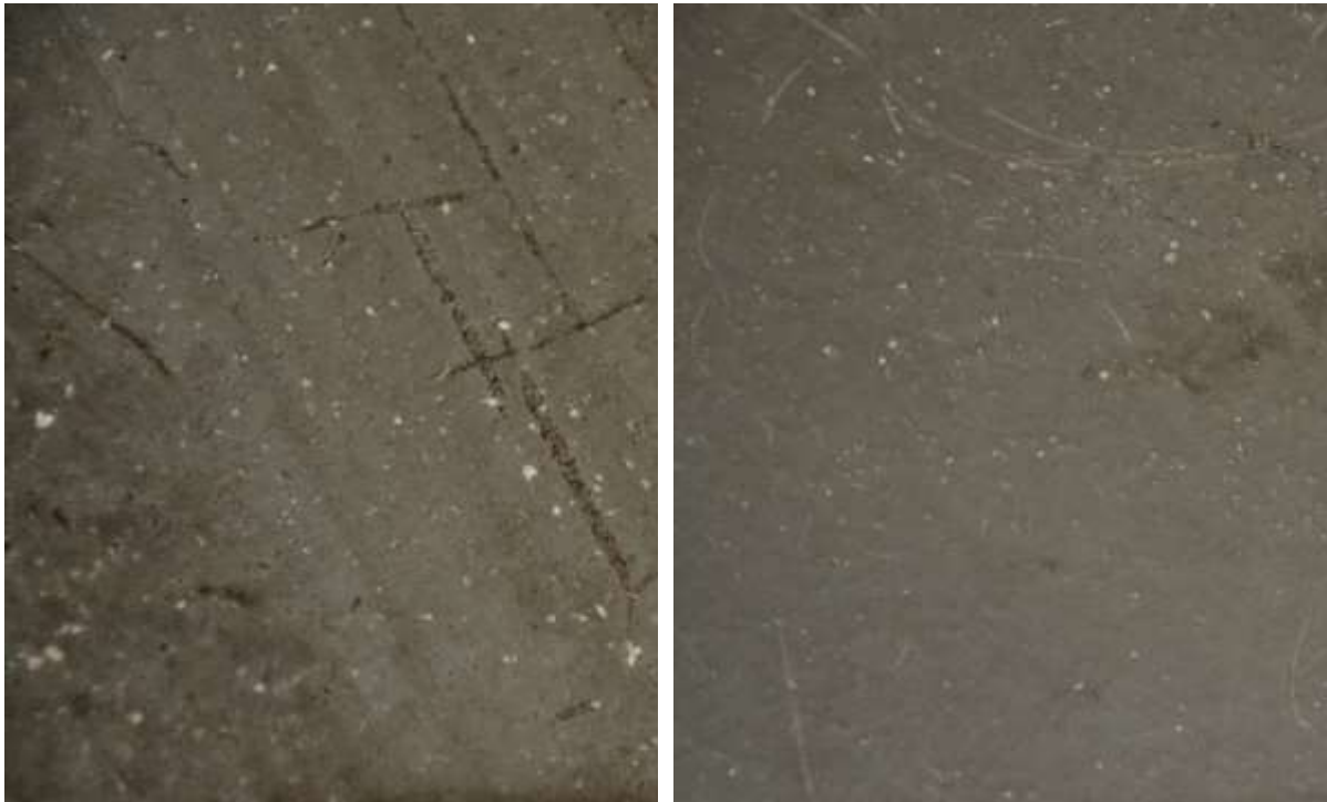
Figur 2.21 Ytligt slitage efter dubbdäck på Polyuretan Ucrete efter 5 år på parkeringsdäcket i Åkeshov
