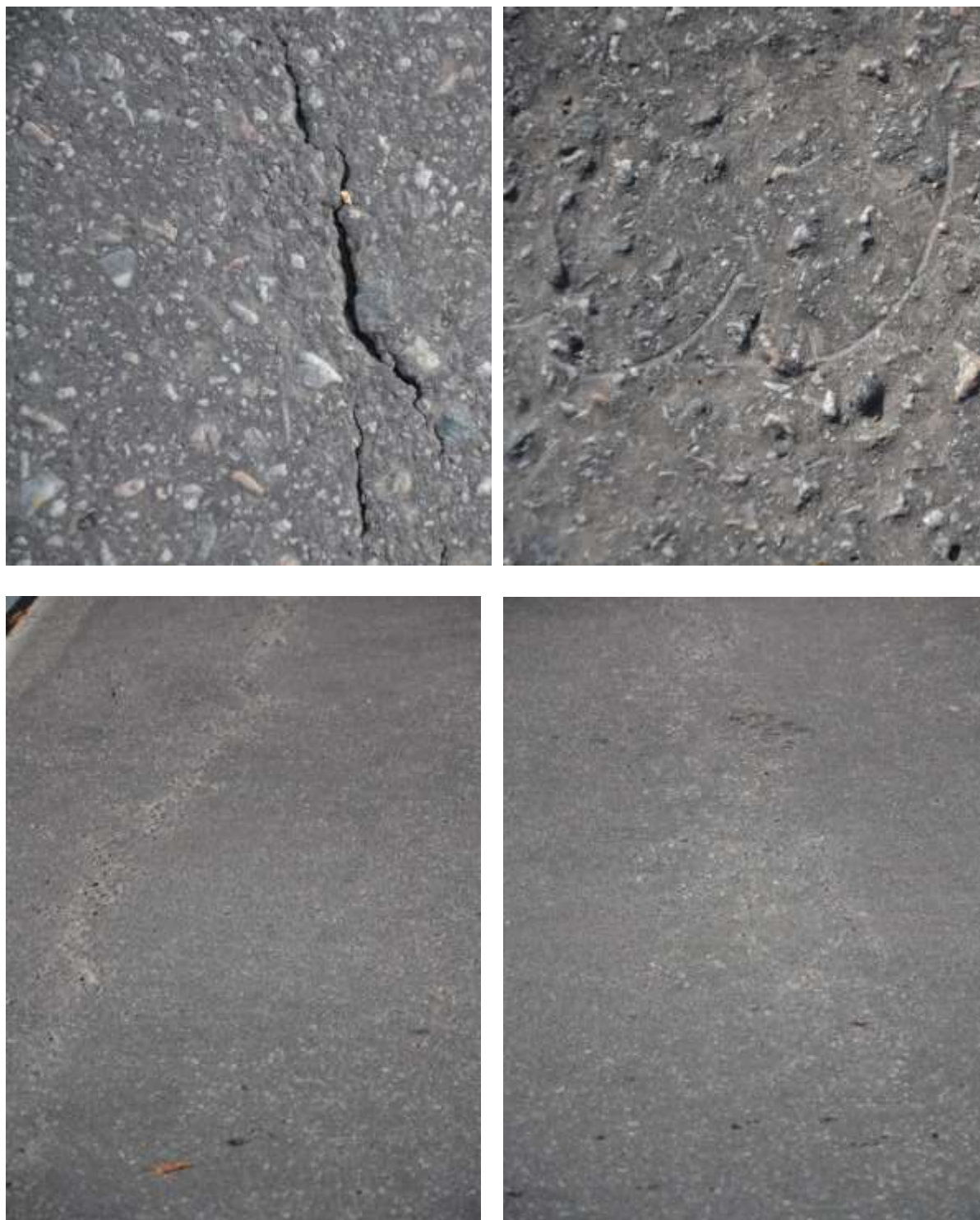
Figur 2.31 Gjutafalt PGJA 11 efter 4 år på parkeringsdäcket i Baggen 2019
