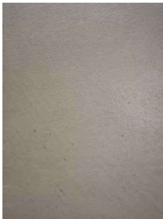
Figur 2.10 Ytligt slitage efter dubbdäck på Polyuretan Deckshield ID efter 6 år på parkeringsdäcket i Kville
