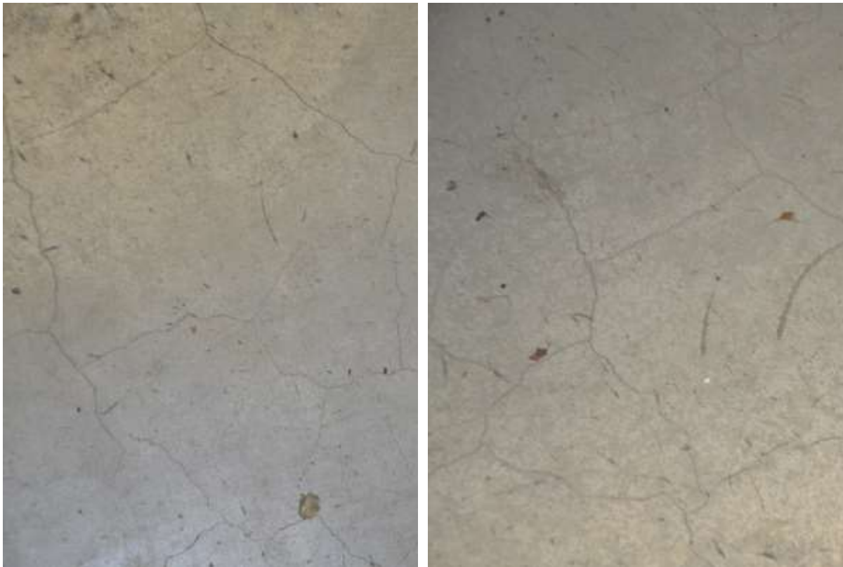
Figur 2.23 Ytligt slitage efter dubbdäck på Hårdbetong Mastertop efter 5 år på parkeringsdäcket i Åkeshov
