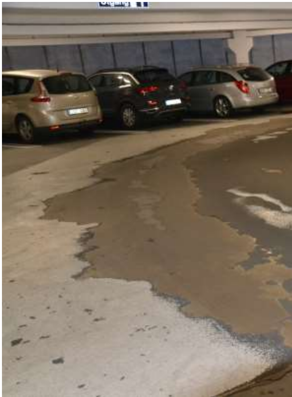
Figur 2.35 Nedsliten beläggning på ramper i Baggen 2019 (ej inom SBUF-projektet)
