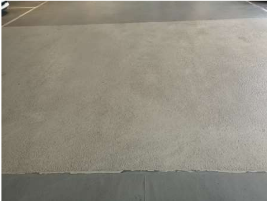
Figur 2.7 Polyuretan StoCretec på parkeringsdäcket i Kville 2019
