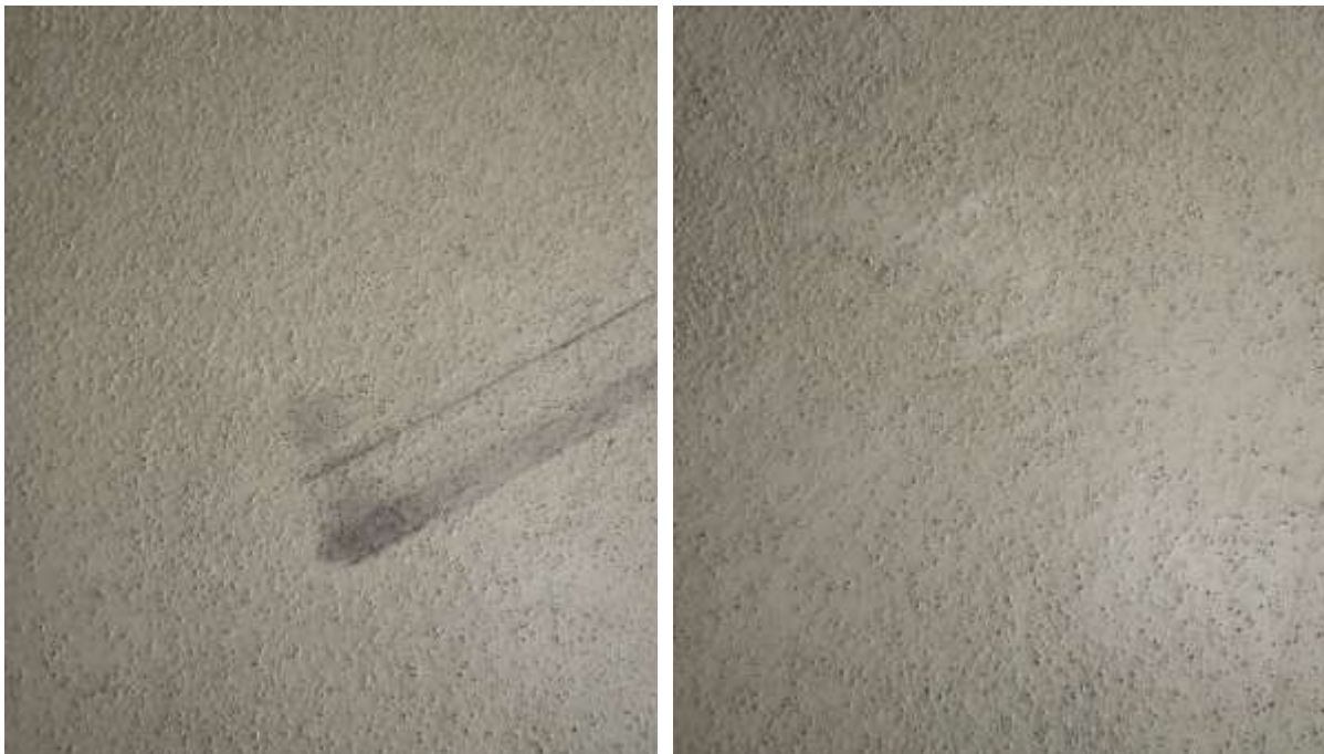
Figur 2.8 Ytligt slitage efter dubbdäck på Polyuretan StoCretec efter 6 år på parkeringsdäck i Kville
