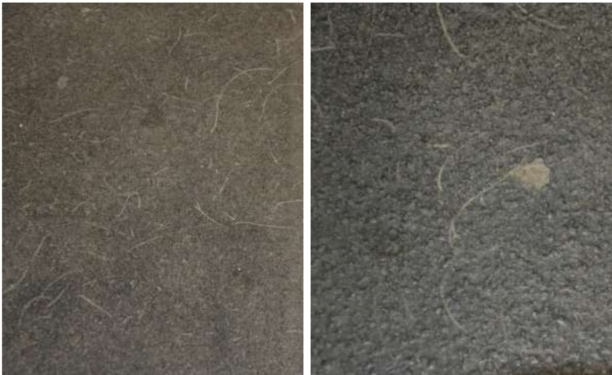
Figur 2.19 Ytligt slitage efter dubbdäck på Akryl Duracon efter 5 år på parkeringsdäcket i Åkeshov
