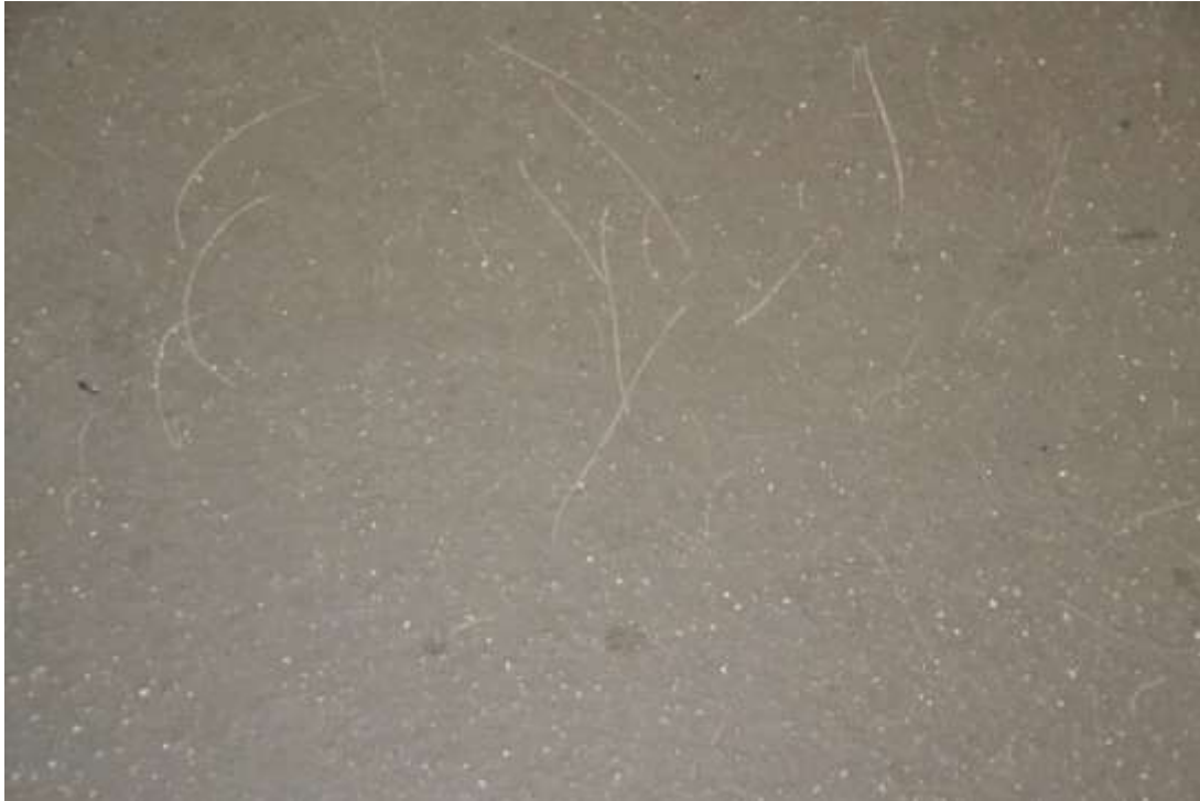
Figur 2.20 Polyuretan Ucrete på parkeringsdäcket i Åkeshov 2019
