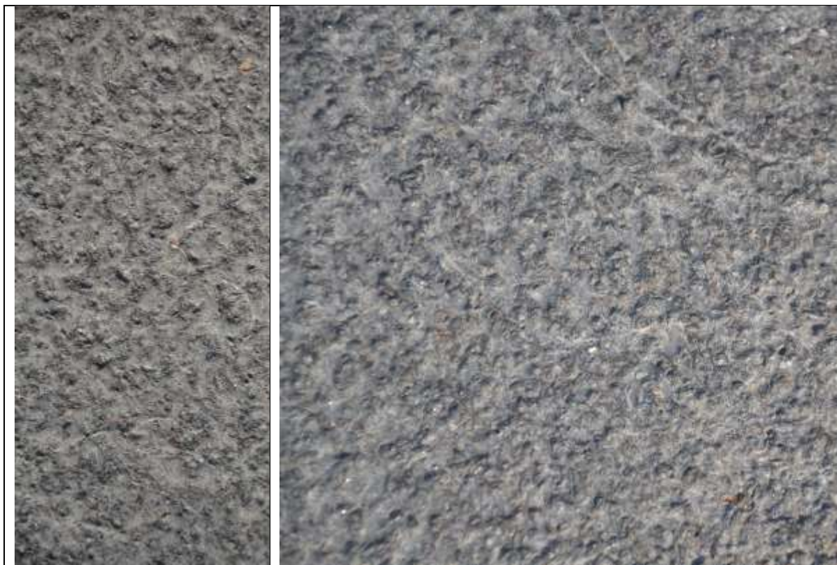
Figur 2.34 Akryl Duracon med ytligt slitage efter drygt 4 år på parkeringsdäcket i Baggen 2019
